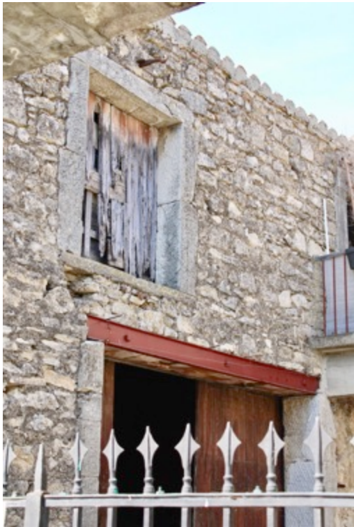
Création d'un logement
