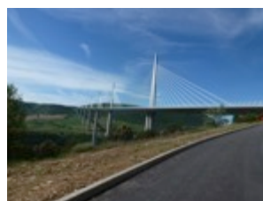
Le viaduc de Millau
